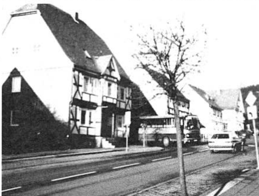
Die abknickende Vorfahrt der L 776 ist unübersichtlich und durch den Verkehr stark belastet
